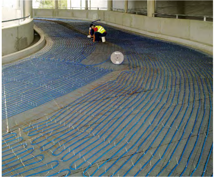
Pričvrščivanje grejnog kabla na instalacijsku mrežu
