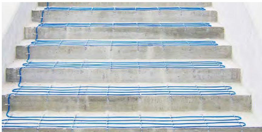
Primer rasporeda grejnih kablova ELEKTRA
