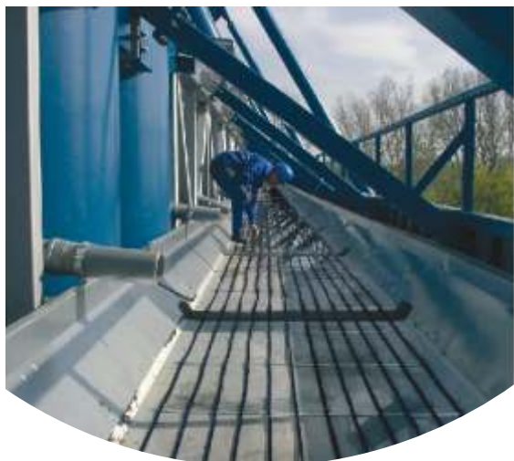
Procedura pričvršćenja kablova u uvalama
