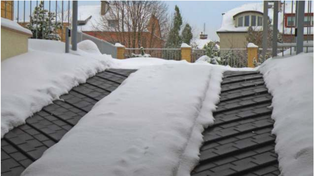
Prilazna rampa grejana sa ELEKTRA SnowTec® grejnom mrežom
